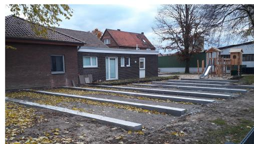
Die Streifenfundamente für den großen Anbau mit Gruppenraum, Sanitäranlagen etc. sind fertig!
